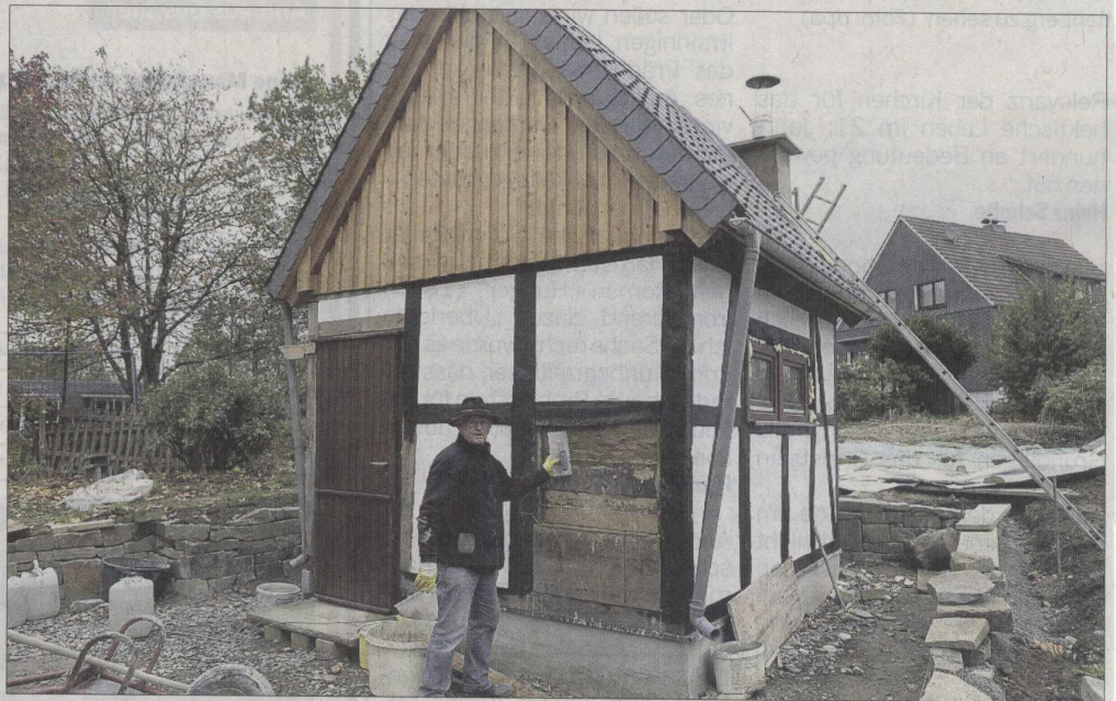
Ehrenamtlicher Einsatz: Klemens Braun beim Bau des Backhäuschens in Wipperfeld, das zu einem Treffpunkt im Dorf werden soll. (Foto: Schmitz)
